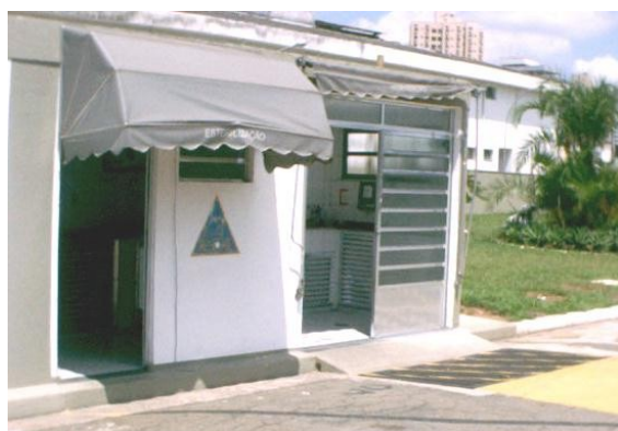
Fachada das salas de Esterilização e Higienização
